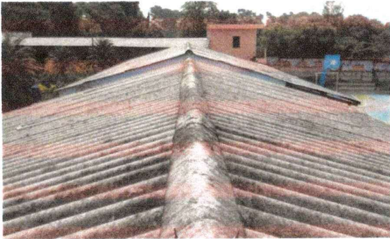
FOTO 1: Módulo de aulas 3 y 4: Cambio de cubierta de láminas.
