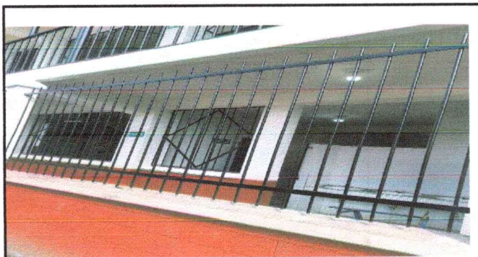
Foto 3: Mantenimiento a barandas de metal modulo 1 y 2.
