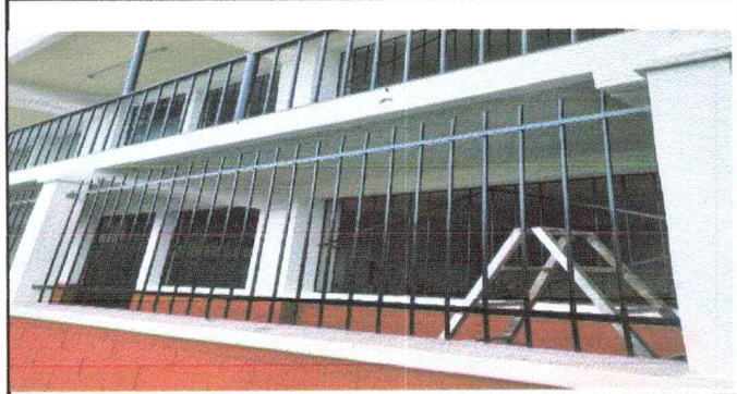
Foto 2: Pintura en muros interior y exterior modulo 1 y modulo 2.
