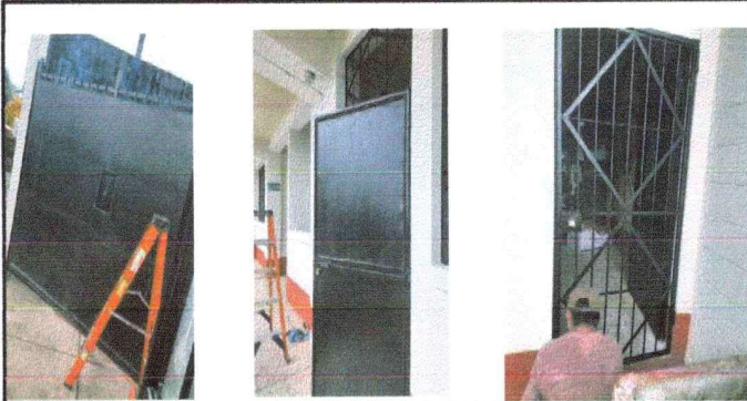
Foto1: Mantenimiento a estructura de puertas de metal modulo 1 y 2, porton principal y fabricación e instalación de puerta tipo baranda para bodega modulo 1.
