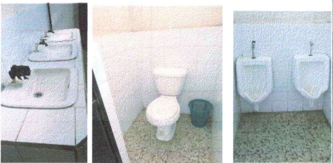
Foto 5: Sustitución de lavamanos, sanitarios y migitorios modulo 2
