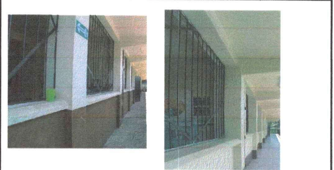
Foto 4: Mantenimiento en ventanas de balcones de metal modulo 1 y 2.
