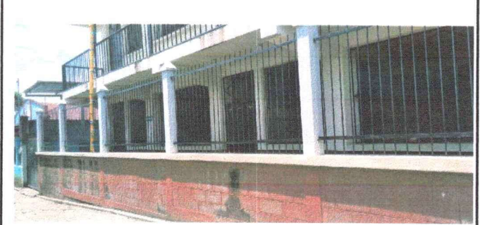
Foto 2: Pintura en muros interior y exterior modulo 1 y modulo 2.
