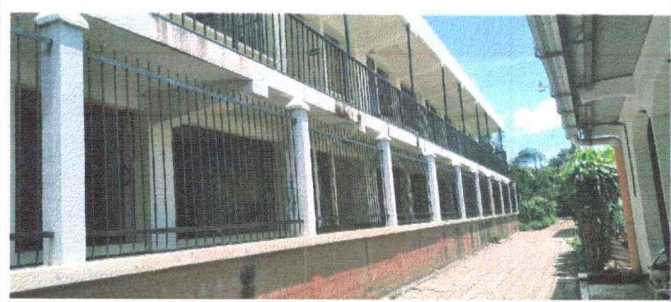
Foto 1: Mantenimiento a estructura de puertas de metal modulo 1 y 2, porton principal y fabricación e instalación de puerta tipo baranda para bodega modulo 1.
