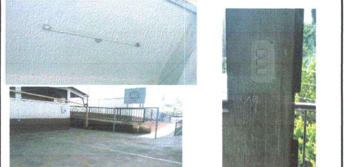
Foto 6: Reparación de sistema electrico modulo 1 y 2, sustitución de plafoneras, lamparas por focos ahorradores en el modulo 1 y 2, suministro de cableado electrico y sustitución toma corriente modulo 1 en area de cancha y modulo 2 en aula, interruptores
