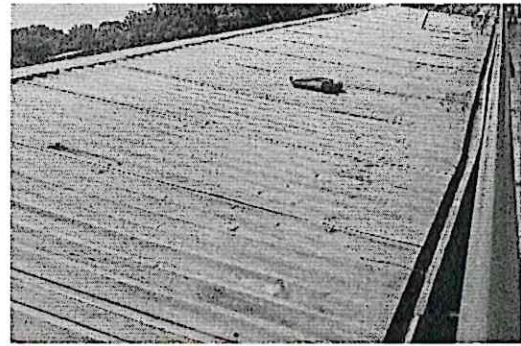
Foto 6: Sustitución de lamina
