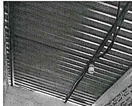
Foto 6: Reparación de sistema electrico
