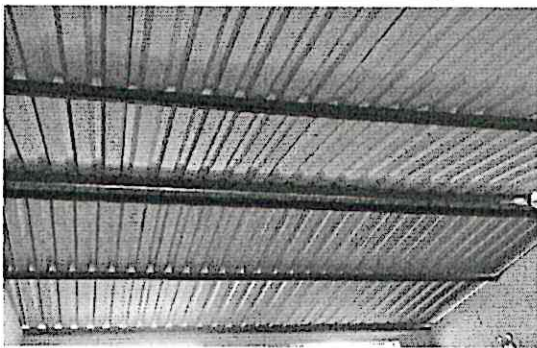
Foto 5: Sustitución de lamina
