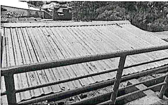
Foto 5: Canales y bajada de agua
