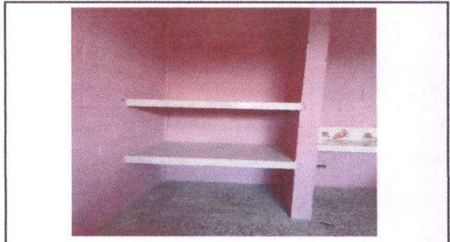
Foto 2: Suministro de Gabinete con divisiones para recipientes 2.46 M A. 1.40 ML revestido de azulejo
