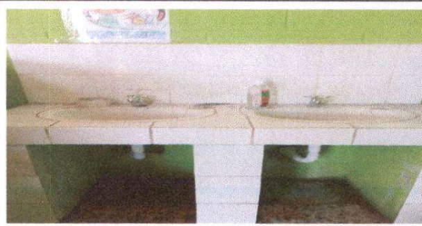
Foto 6: Sustitucion de mezcladoras de lavamanos
