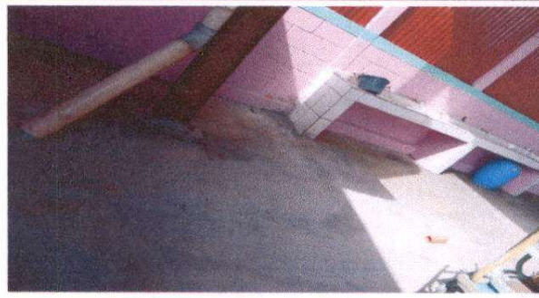
Foto 4: sustitucion de tuberia de drenaje
