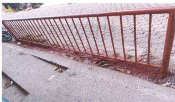
Foto1: Pintura de baranda (lijado, cepillado, pintura anticorrosiva)
