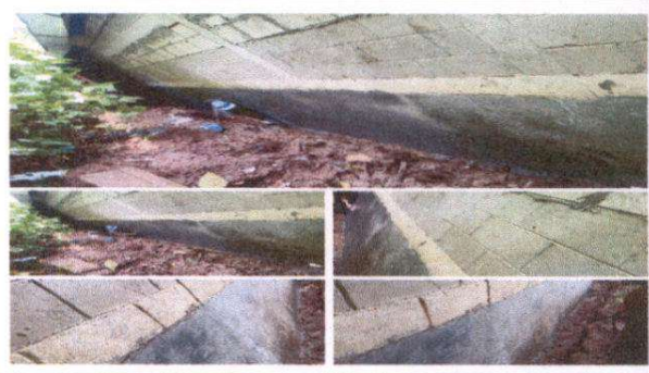
Foto 2: Repello y cerrnido de Pared
