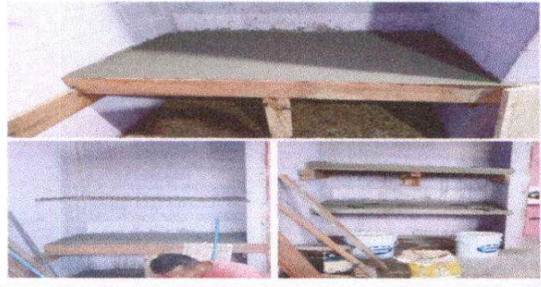
Foto 2: Suministro de Gabinete con divisiones para recipientes 2.46 M A. 1.40 ML revestido de azulejo
