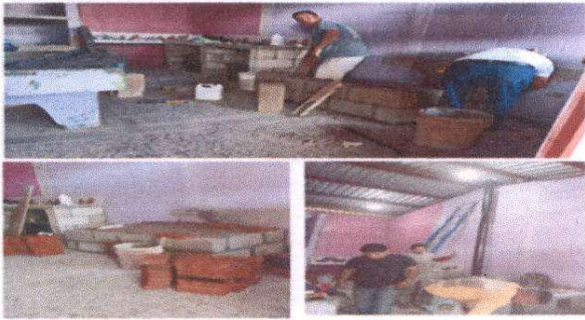
Foto1: Suministro de polleton con chimenea y plancha de 1.54 por 88
