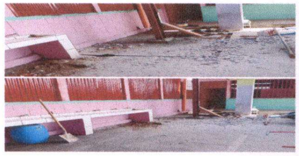
Foto 4: sustitución de tubería de Drenaje
