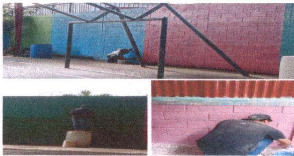
Foto 5: Pintura en muros interiores y exteriores
