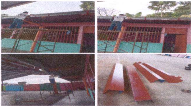
Foto 3: Sustitución de canal de metal cal. 26 sujetado con angulares de 1"X1"
