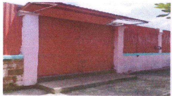
foto 4 instalacion y ampliación de portón
