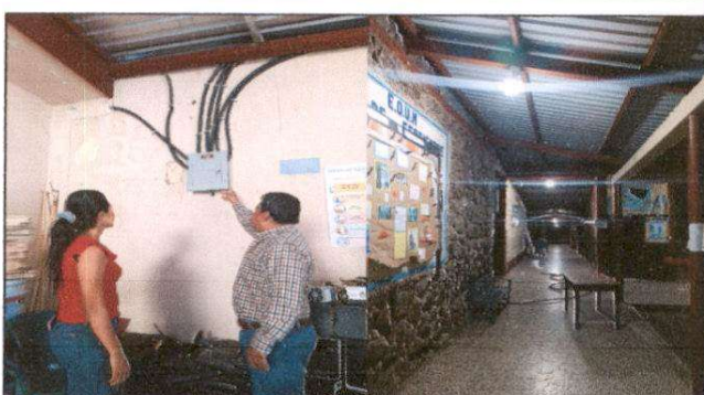
Foto 4: Reparación de sistema eléctrico (sustitución de cableado eléctrico)
