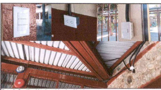
Foto 6: Sustitución de cableado eléctrico (sustitución de flipones, plafoneras, interruptores, tomacorrientes y caja de tablero)
