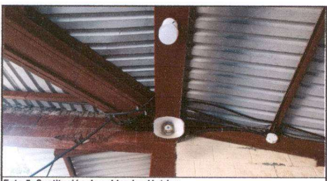
Foto 5: Sustitución de cableado eléctrico
