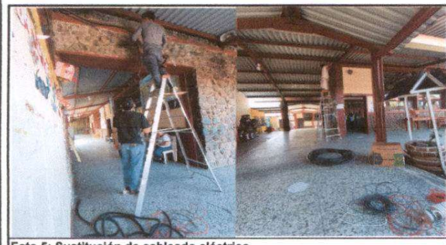
Foto 5: Sustitución de cableado eléctrico
