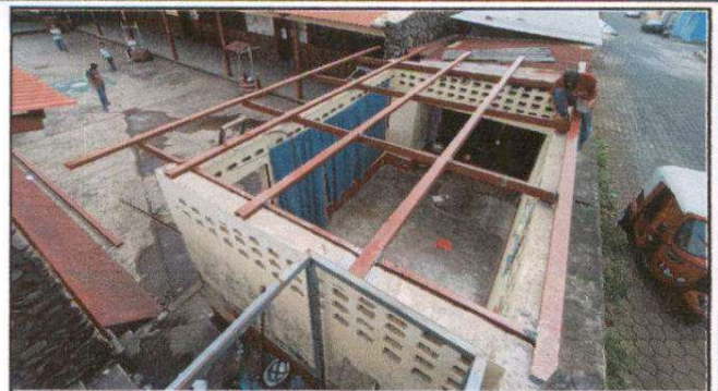
Foto 2: Sustitución de cubierta de lámina por lámina troquelada calibre 24
