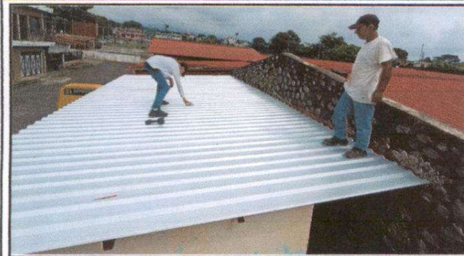
Foto 1: Sustitución de cubierta de lámina por lámina troquelada calibre 24
