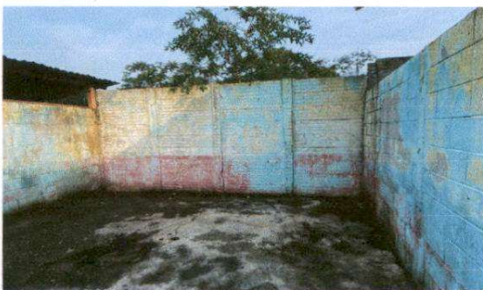
Repello reparación de muro de area de cocina
