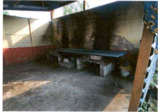
Sustitucion de estufa rural (completa) incluye chimenea y plancha de metal
