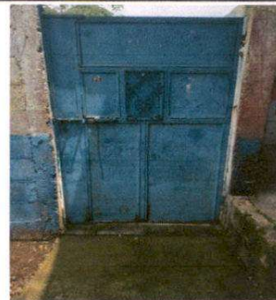
Sustituación de puerta. Area de cocina
