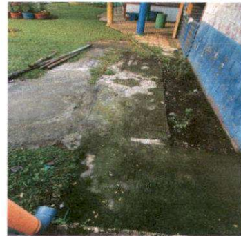
Reparación de planchas de concreto de patio
