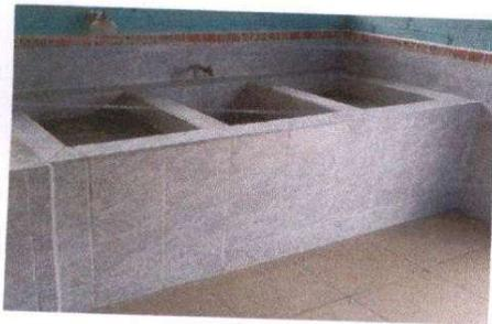
Instalación de pila 1.60 mts de largo por 0.80 cms de ancho por 0.80 cms de alto
