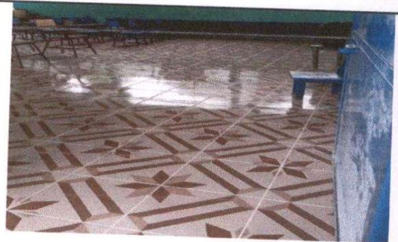
Sustitución de piso de torta de concreto por cerámico. (CUBIC BEIGE 008755)
