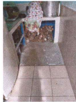
Sustitución de piso de torta de concreto por cerámico. (CUBIC BEIGE 008755)
