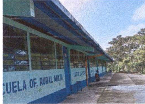
PISO MÓDULO 1 AULAS 1, 2 Y 3.
