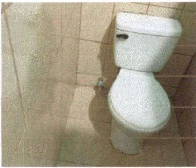
Sustitución de accesorios inodoro (contra llave, tubo de abasto y tanque)
