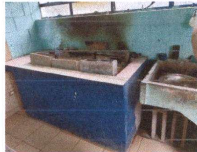
Sustitución de Estufa Rural (completa incluye chimenea y plancha de metal).
