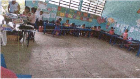
Sustitución de piso de torta de concreto por cerámico. (CODIGO (ANORA MARBLE 2006333)
