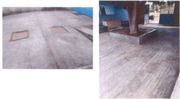
Foto 2: Reparación de planchas de concreto de patio
