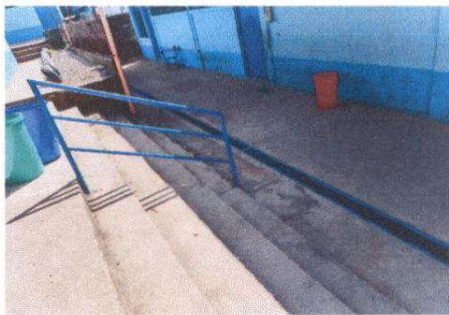
Foto 3: Suministro de rejilla
