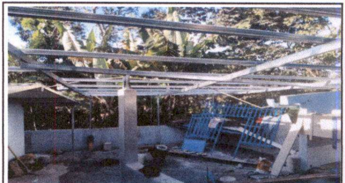
Foto 4: Sustitución de cubierta de lámina troquelada calibre 26.
