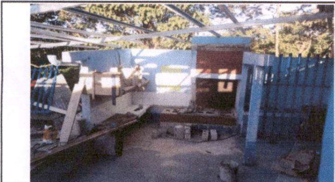
Foto 3: Sustitución de estufa rural (completa) incluye chimenea y plancha de metal. Reparación de azulejo en muebles de cocina.
