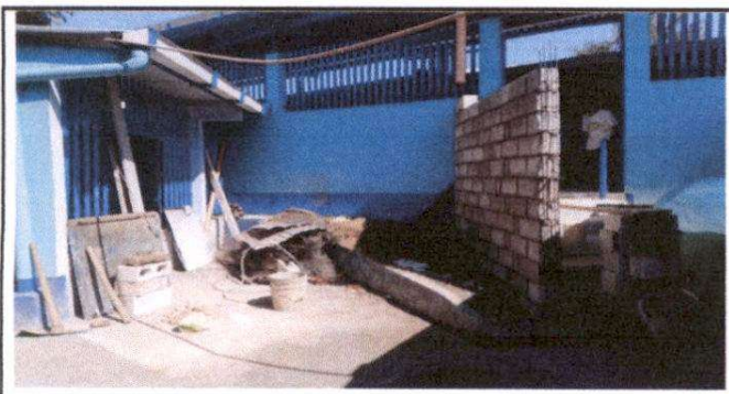
Foto 5: Reparación de cocina.
