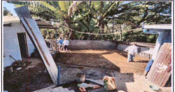
Foto 2: Reparación de plancha de concreto de patio.
