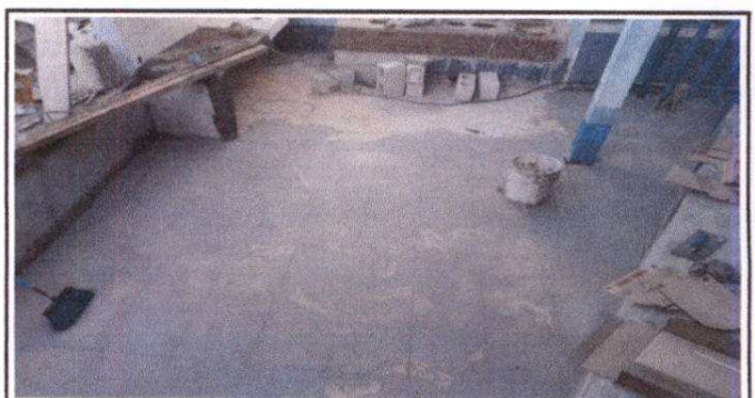
Foto 6: Reparación de piso cerámico de la cocina.
