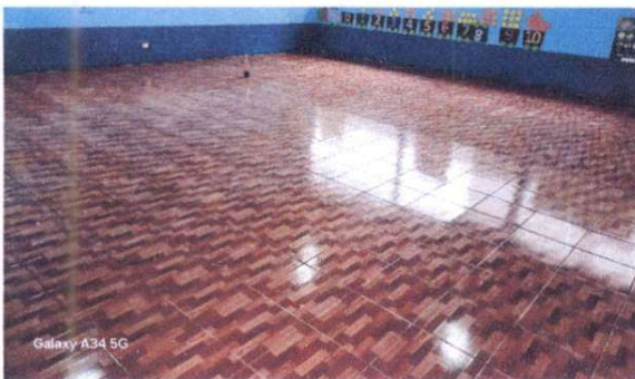
Foto 5: Sustrucción del piso en el aula
