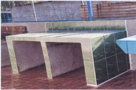
Foto 3: Sustrucción mesa de concreto
