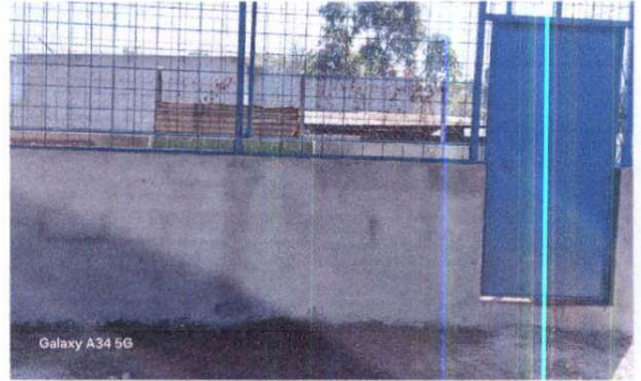
Foto 2: Sustrucción de lámina y estructura de madera por metal
