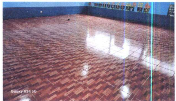
Foto 6: Sustrucción del piso en el aula
