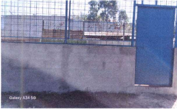
Foto 1: Sustrucción de cocina.
