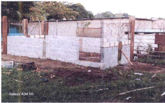
Foto 3: Sustitución mesa de concreto
