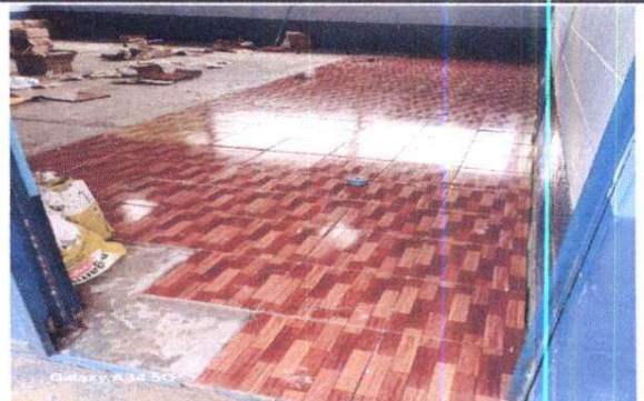
Foto 6: Sustitución del piso en el aula
