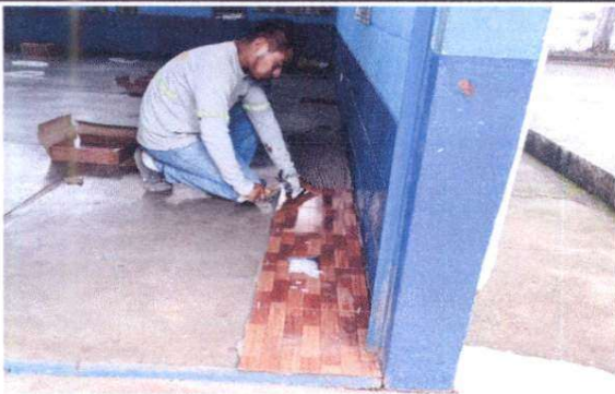
Foto 5: Sustitución del piso en el aula
