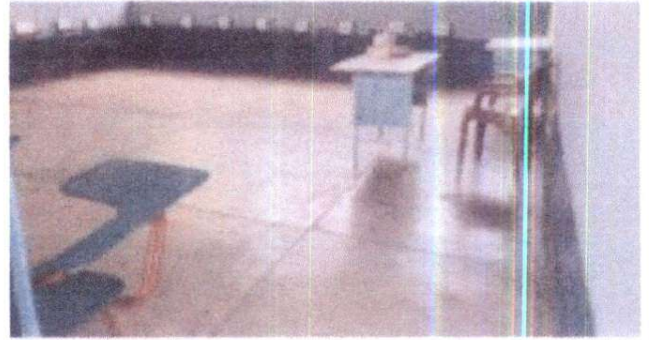
Foto 6: Sustitución del piso en el aula
