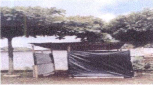
Foto1: Sustitución de cocina.
