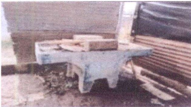
Foto 3: Sustitución mesa de concreto
