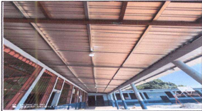
Foto 3: Techado y costaneras nuevas.
