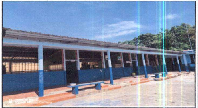
Foto 2: Se evidencia techado y costaneras ya nuevas.
