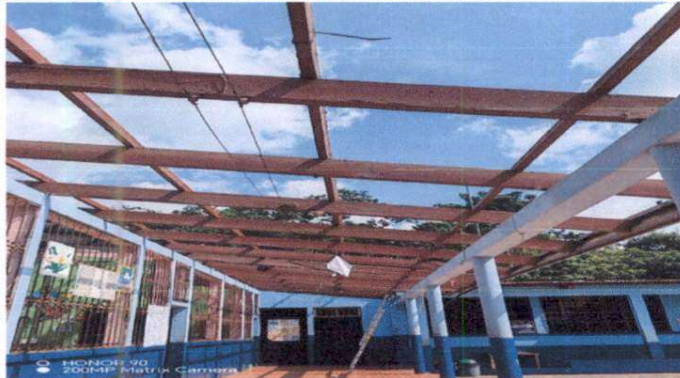
Foto1: Se puede observar los tendales que ya no cuentan con la estructura de las láminas.
