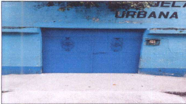
Foto 1: Cambio y suministro de porton y rampa de ingreso
