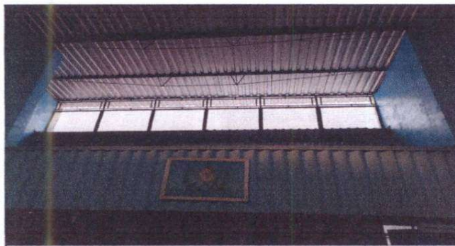
Foto 5: Colocación de lamina transparente en cubierta
