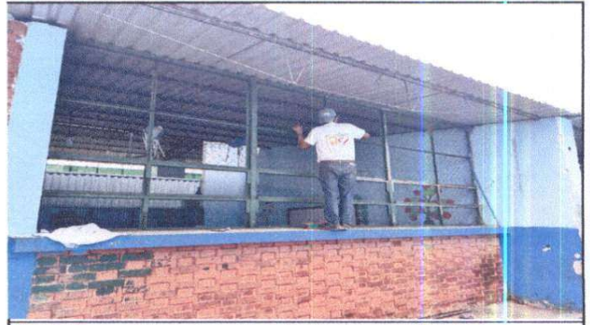
Foto 2: Mantenimiento para aplicación de pintura en balcones
