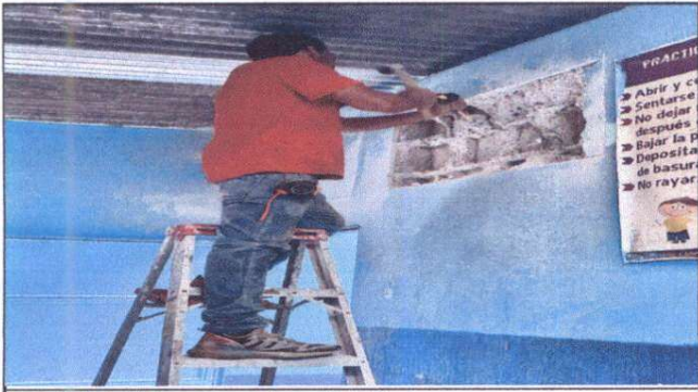
Foto 1: Demolición para ventana y balcón
