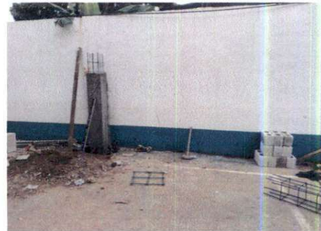
Foto 12: Refuerzo con columnas en el muro perimetral.
