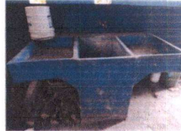
Foto 2: Esta pila se encuentra en el área de la cocina y se realizará colocación de azulejo
