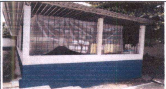
Foto 11: Los salones de cuarto primaria no tienen ventanas, provisionalmente se ha colocado naylon. Instalación de ventanas de vidrio y colocación de block en la parte de enfrente
