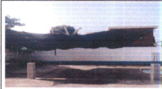
Foto 8: Esta área es donde los niños realizan actividades deportivas y culturales, para evitar los rayos del sol se ha colocado una manta y la misma esta sujeta al barandal del segundo nivel, instalación de tubos rellenos galvanizados y costaneras en muros.
