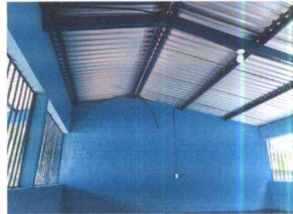
Foto 4: REPARACIÓN DE SISTEMA ELECTRICO
