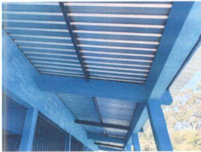
Foto 3: SUSTITUCIÓN DE LAMINA
