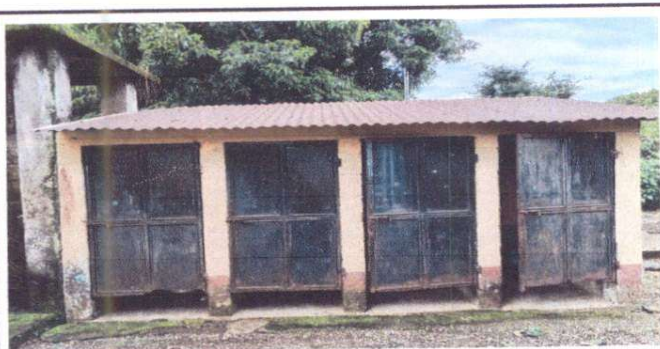
Foto 5: Reparación de servicios sanitarios
