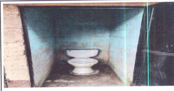
Foto 6: Reparación de servicios sanitarios
