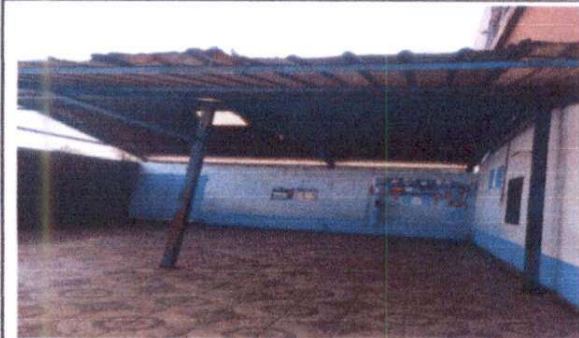
Sustitución de Lámina por lámina Troquelada aluzinc calibre 26 y sustitución de estructura de soporte de metal, por metal.
