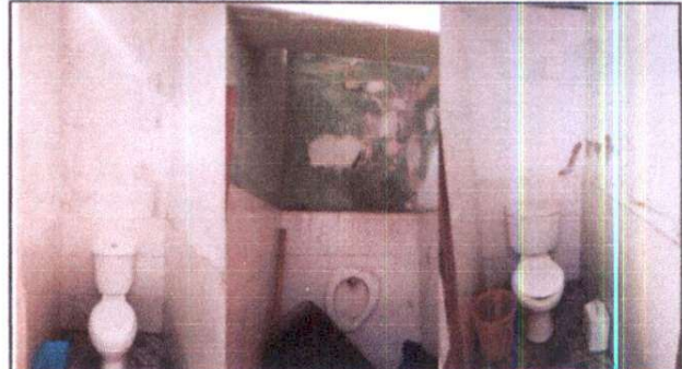
Instalación de Azulejo
