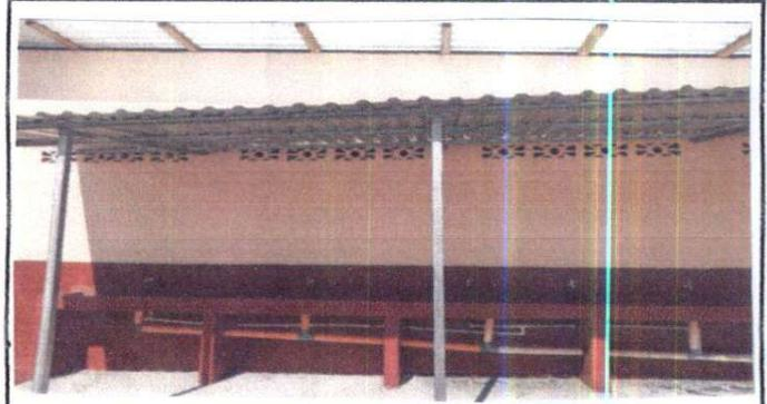
Mantenimiento de lavamanos de concreto. Sustitución de estructura de soporte de metal. Instalación de lámina troquelada. Pintura
