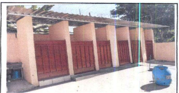
Sustitución de estructura de metal por metal. Sustitución de lámina por lámina troquelada. Pintura
