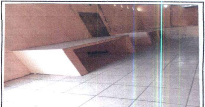
Sustitución de mesas de madera por mesas de trabajo de concreto. Sustitución de piso de concreto por piso cerámico.
