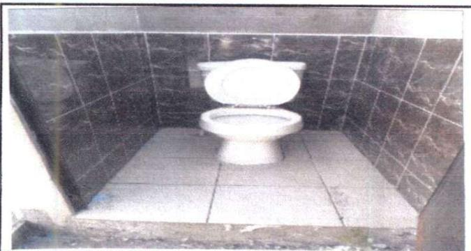
Sustitución de piso de concreto por piso cerámico. Sustitución de accesorios para sanitarios.
