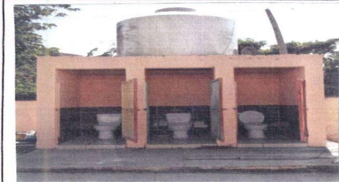
Sustitución de azulejo en sanitarios. Sustitución de inodoro. Instalación de depósito de agua de 2,500 litros con sus accesorios. Suministro de tubería pvc de línea principal aguas negras. Pintura
