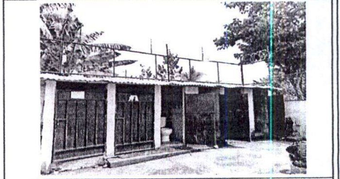
Foto 2: A) sustitución de lamina por lamina troquelada. B) sustitución de estructura de soporte de metal. C) instalación de azulejo. D) sustitución de accesorios de sanitarios
