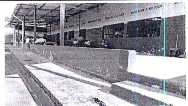
Foto 6: A) Pintura en muros exteriores e interiores
