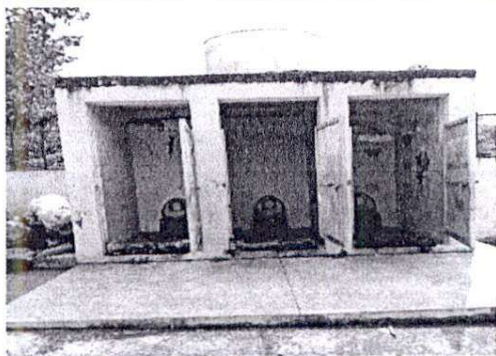
Foto 3: A) Sustitución de letrinas por sanitarios. B) Suministro de tubería pvc de línea principal de aguas negras. C) Sustitución de deposito de agua de 2500 litros
