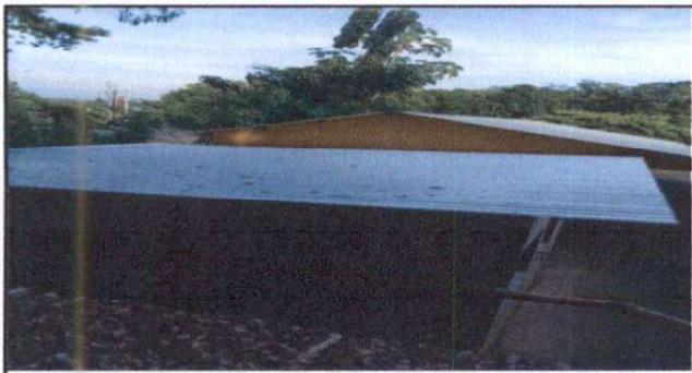
Foto 3: Techado con láminas y costaneras en el aula.
