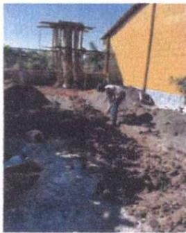
Foto 3: Escarbación para instalación de tubería de agua potable.
