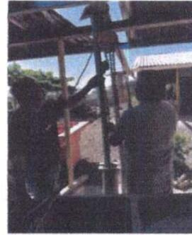
Foto 2: Instalación de bomba sumergible.
