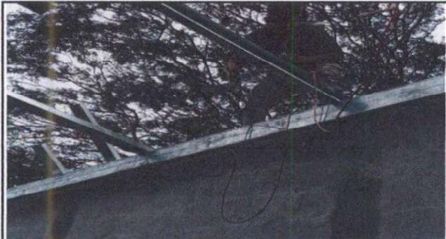
Foto 3: Sustitución de tendales de madera por costaneras de metal
