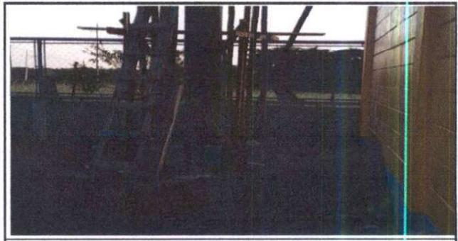
Foto 6: Construcción de base para instalar el rotoplas
