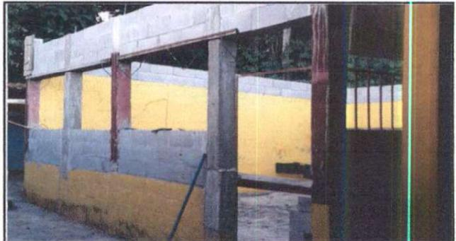
Foto 2: Colocación de block y columnas para remozamiento del aula.
