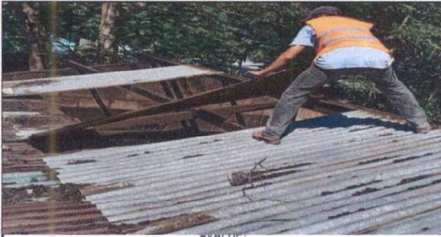
Foto1: Sustitución de laminas clasicas inservibles por lamina troquelada
