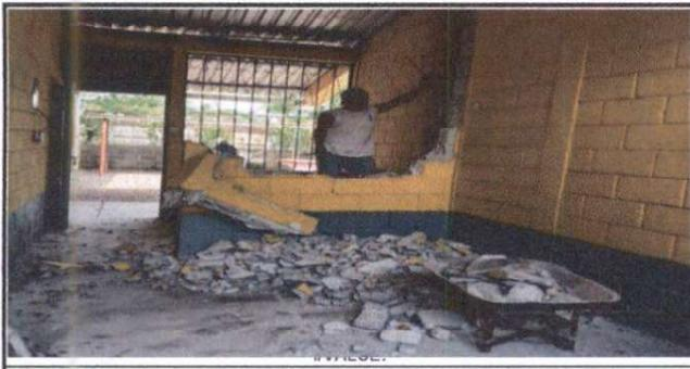
Foto 5: Demolición de pared para construir el polletón y la pila con desayunador dentro de la cocina
