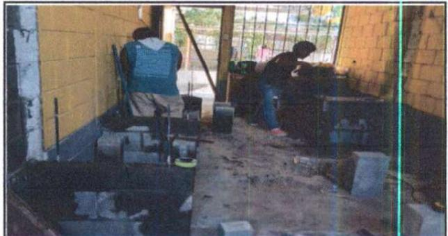
Foto 4: Construcción de pila de 1 mt. de largo por 90 cms de ancho por 80 cms de alto dentro de la cocina.
