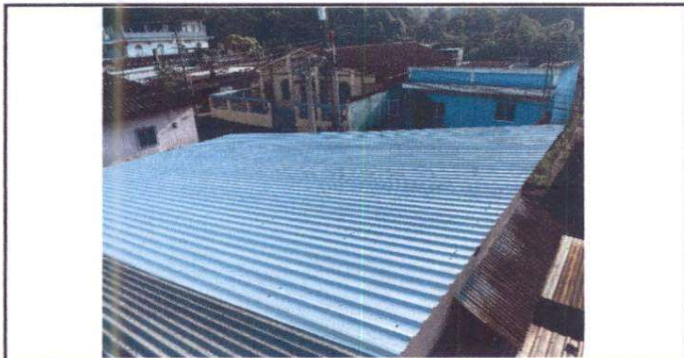
Foto 11: Sustitución de lámina por lámina en aula.
