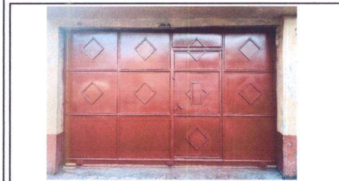
Foto 3: Mantenimiento a portón de metal principal.
