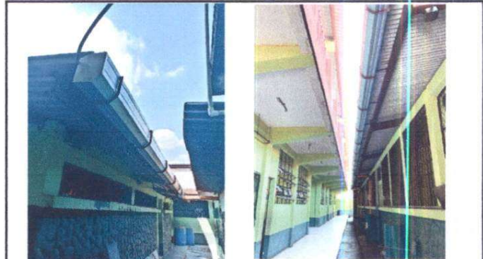
Foto 10: Suministro de canal en cocina y aulas del módulo I.
