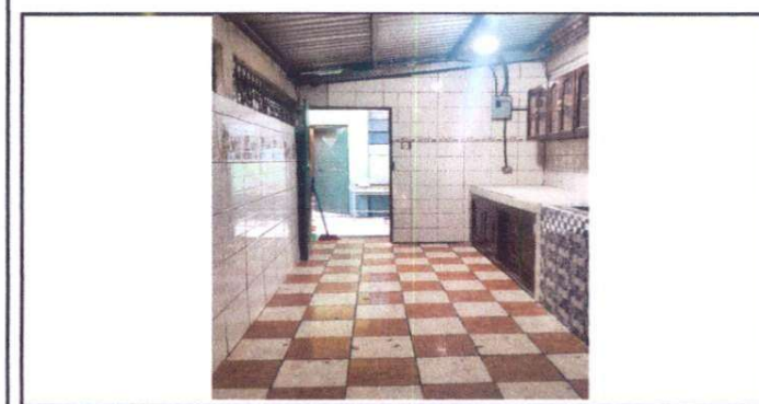
Foto 5: Suministro de azulejos en pared lateral, sustitución de filtro de agua, sustitución de pila de concreto de un lavadero, reparación de puerta de madera de gabinete.
