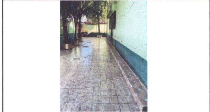
Foto 8: Sustitución de piso cerámico en andén y área de patio.
