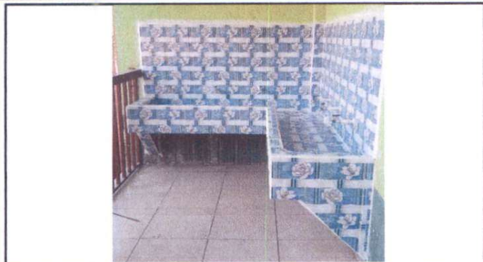
Foto 13: Suministro de lavamanos en el módulo 2 de concreto revestido de azulejo con 6 chorros, incluye tubería y accesorios.
