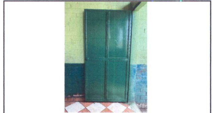
Foto 2: Lijado, cepillado, sujeciones y aplicación de pintura en puertas de aulas, baño y cocina.
