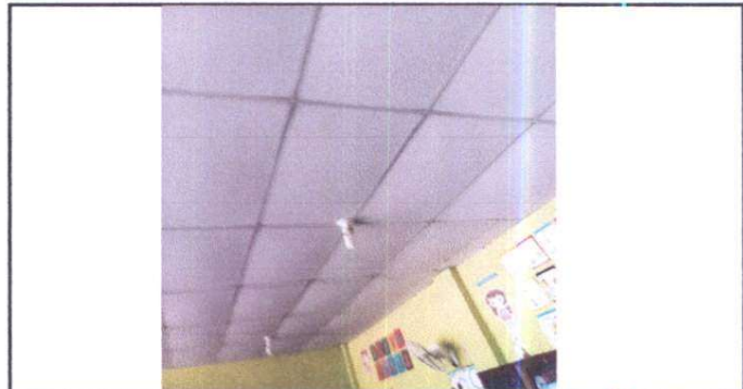
Foto 12: Reparación de cielo falso en aulas del segundo nivel.
