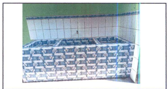
Foto 6: Sustitución de pila de cemento de dos lavaderos fuera de la cocina.
