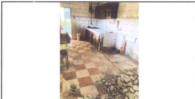
Foto 5: Suministro de azulejos en pared lateral, sustitución de filtro de agua, sustitución de pila de concreto de un lavadero, reparación de puerta de madera de gabinete.
