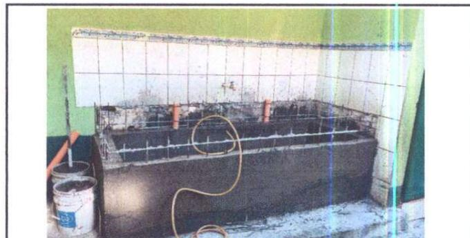
Foto 6: Sustitución de pila de cemento de dos lavaderos fuera de la cocina.
