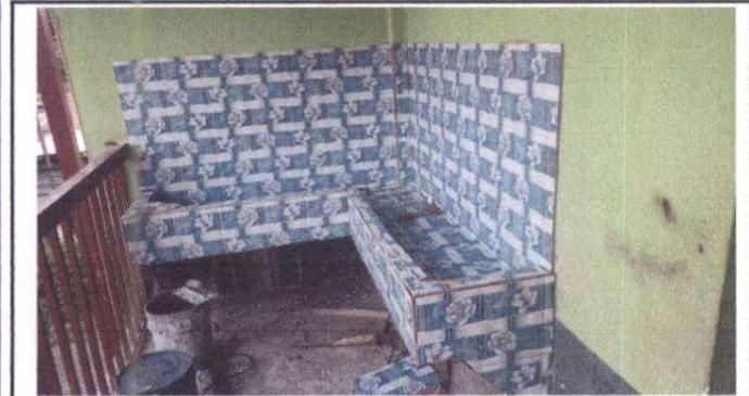
Foto 13: Suministro de lavamanos en el módulo 2 de concreto revestido de azulejo con 6 chorros, incluye tubería y accesorios.
