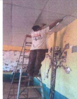
Foto 12: Reparación de cielo falso en aulas del segundo nivel.
