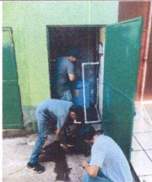
Foto 9: Sustitución de bomba hidroneumática de 1 HP vertical (incluye accesorios y sustitución de instalación eléctrica)
