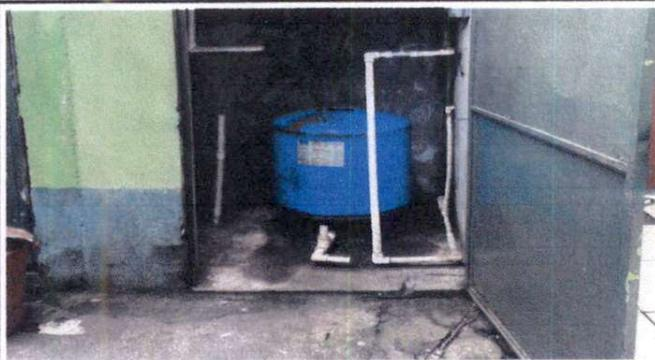
Foto 9: Sustitución de bomba hidronumática de 1 HP vertical (incluye accesorios y sustitución de instalación eléctrica)
