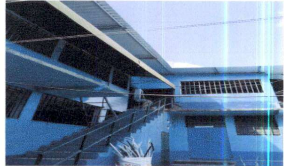
Cambio de lámina y estructura de techo aula 2 segundo nivel
