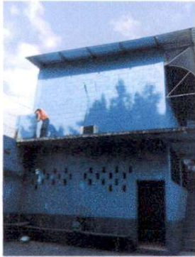
Sustitución de cambio de lámina y estructura de techo aula 1 segundo nivel
