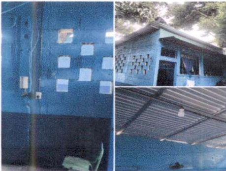
Cambió de lámina y estructura de techo aula 3
