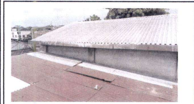
Sustitución de cambio de lámina y estructura de techo aula 1 segundo nivel
