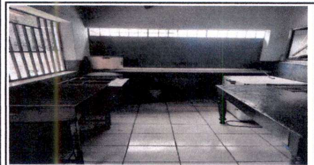
Sustitución de mesa de madre por plancha de concreto azulejado, para la cocina.
