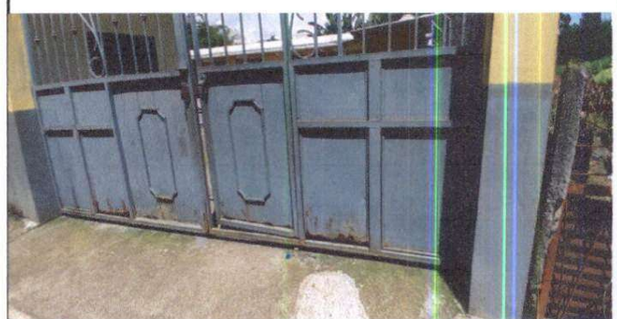
Foto 4: Reparación de portón
