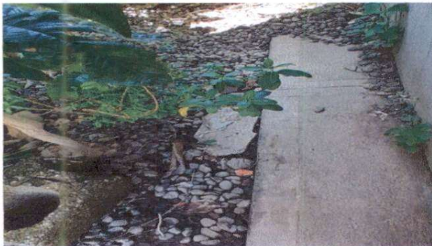
Foto 3: Hecha de zanja con parrilla en patio
