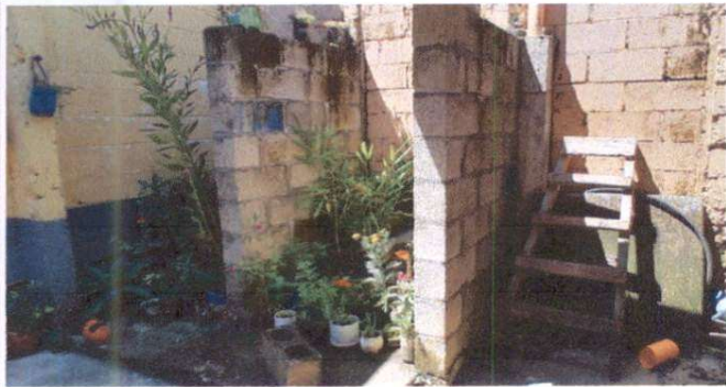
Foto 1: Habilitación de 2 sanitarios
