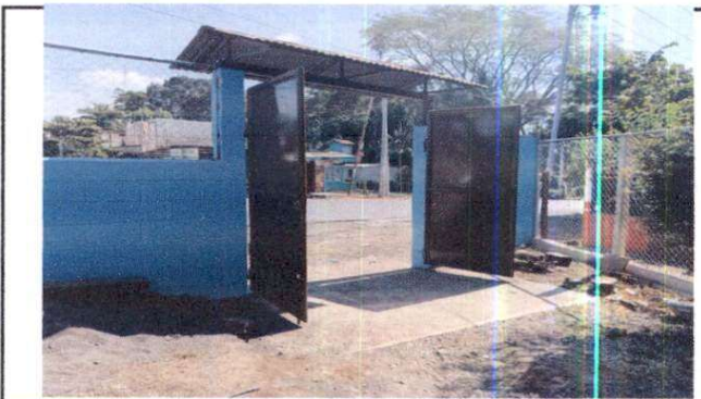
Foto 6: FUNDICIÓN DE TORTA DE CEMENTO PARA NIVELACION DE ENTRADA
