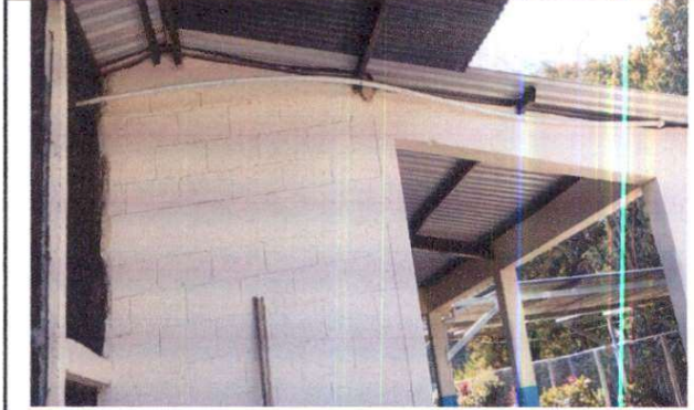
Foto 2: INSTALACION DE TUBERIA DE AGUA POTABLE
