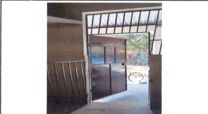
Foto 3: SUMINISTRO DE PUERTA DE METAL
