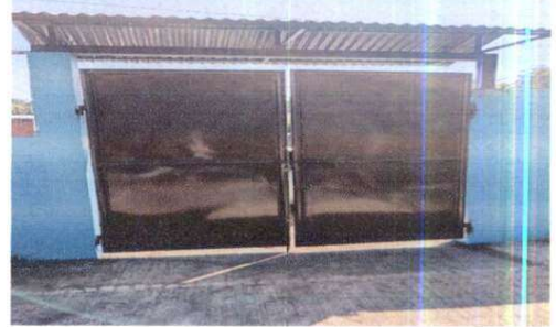
Foto 4: REPARACIÓN DE PORTON ESTRUCTURA METALICA
