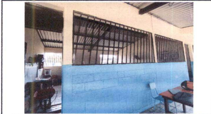
Foto1: INSTALACI'N DE MALLA EN BALCONES
