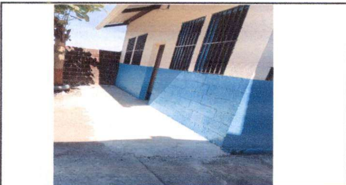
Foto 5: SUMINISTRO DE BANQUETA DE CONCRETO
