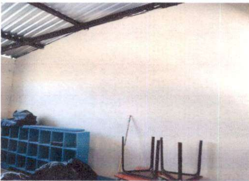
Foto 3: REPELLO Y CERNIDO EN PARED DE DIVICIÓN COCINA Y DIRECCIÓN
