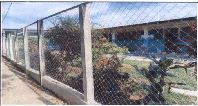
Foto 5: SUSTITUCIÓN DE MALLA GALBANIZADA CON POSTES DE CONCRETO
