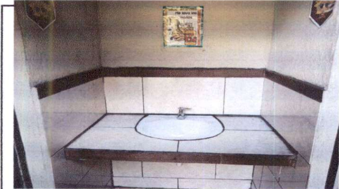
Foto 3: SUMINISTRO DE GRIFO PARA LABAMANOS
