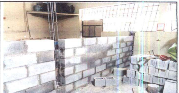
Foto 6: suministro de pared de Block para dividir dirección y cocina
