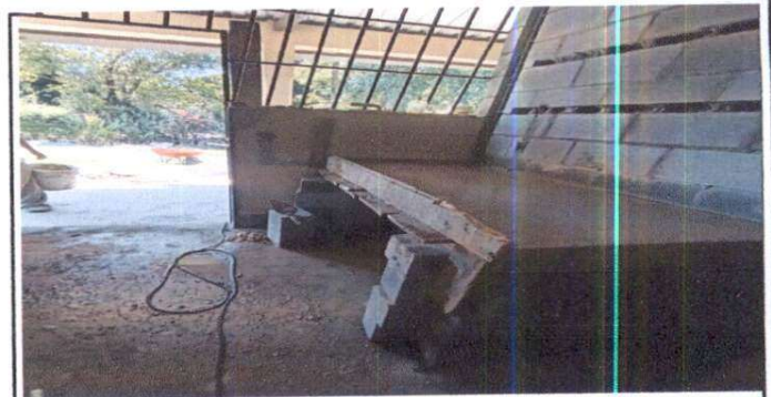
Foto 6: Realización de cocina gabinete
