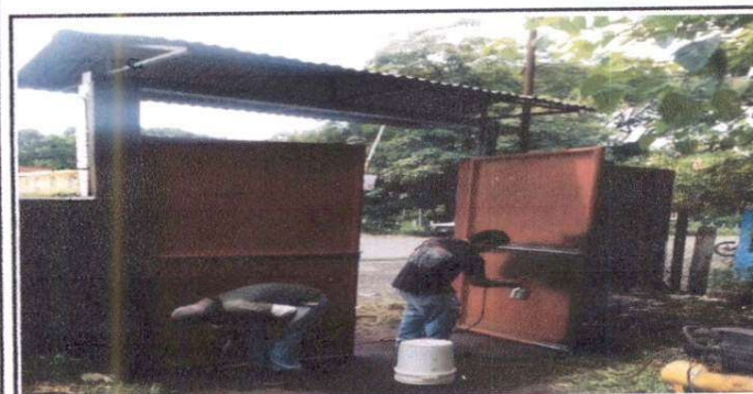
Foto 5: Sustitución de porton de entrada de establecimiento
