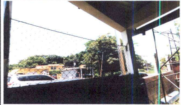
Foto 2: sustitucion de canal de agua
