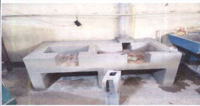
Foto 1: sustitución de cocina
