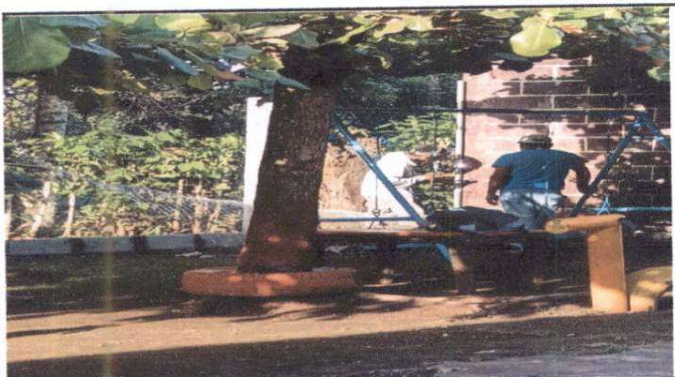
Foto 3: sustitución de malla area perimetral
