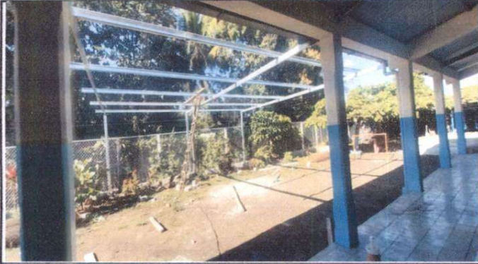
Foto 1: elaboración de estructura de metal y laminado
