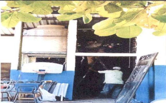
Foto 3: colocacio'n de rotoplas para sanitarios
