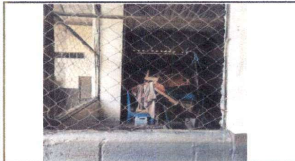
Foto 3: area de bodega donde se colocara rotoplan
