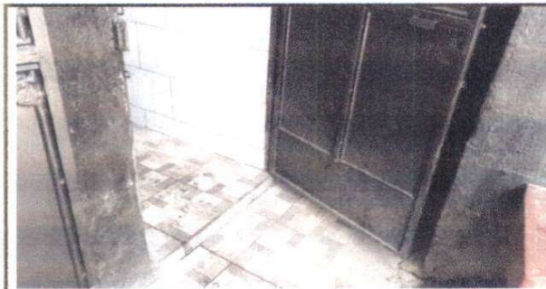
Foto 5: mantenimiento a puertas de baños
