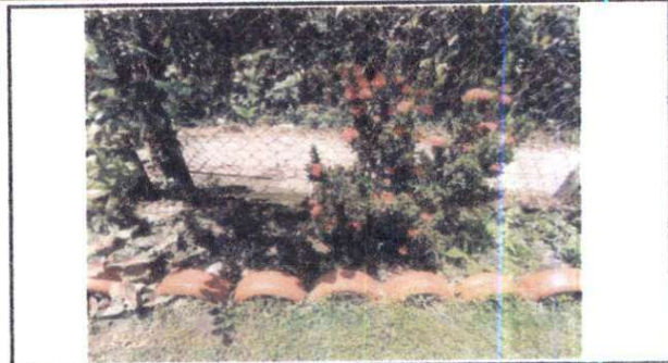
Foto 2: sustitucion de malla en area perimetral de establecimiento
