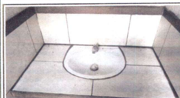
Foto 3: Mantenimiento al area de lavamanos
