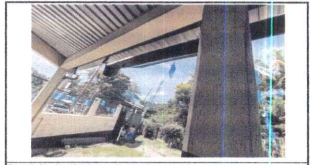
Foto 6: Sustitución de canales de agua pluvial
