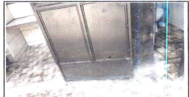
Foto 6: mantenimiento a puertas de baños
