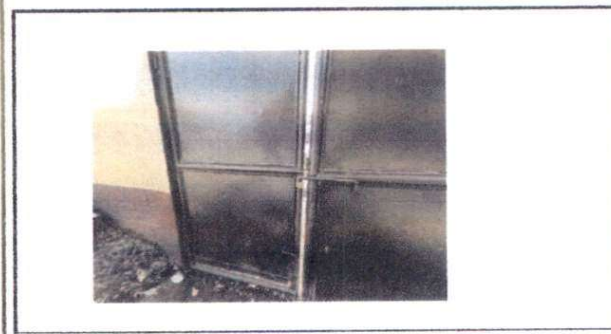
Foto 5: sustitución de portón de entrada de establecimiento
