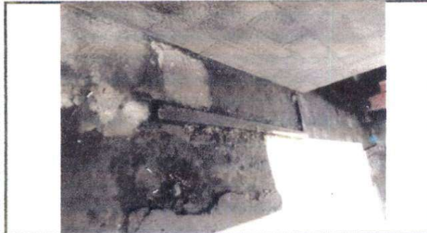
Foto 1: Losa de banquetta
