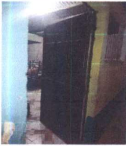
Foto 1: Mantenimiento y puesta de chapa .
