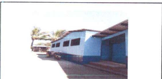
Foto 3: Pintura en muros exteriores.
