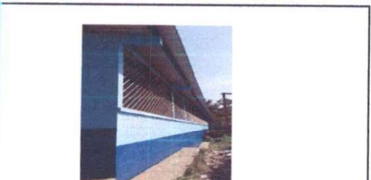
Foto 5: Pintura en muros exteriores.
