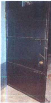
Foto 3: Mantenimiento y puesta de chapa .
