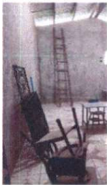
Foto 5: Mantenimiento y puesta de chapa .
