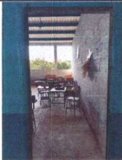
Foto 3: Mantenimiento y puesta de chapa .
