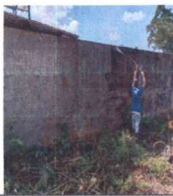
Foto 5: Pinturas en muros exteriores.
