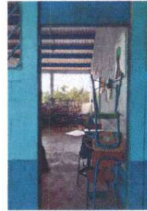
Foto 2: Mantenimiento y puesta de chapas.
