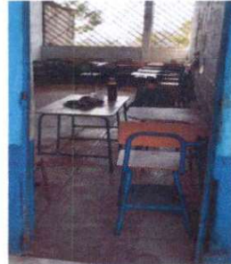
Foto 2: Cambio de puerta incluye chapa.
