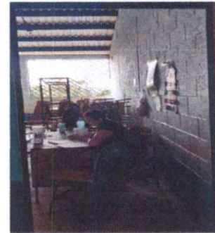
Foto 4: Mantenimiento y puesta de chapa .
