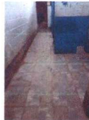
Foto 6: Mantenimiento y puesta de chapa .
