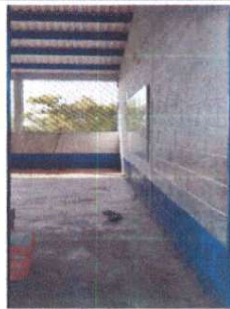
Foto 5: Mantenimiento y puesta de chapa .
