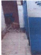
Foto 3: Mantenimiento de puertas baños.
