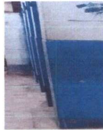
Foto 4: Mantenimiento de puertas baños.
