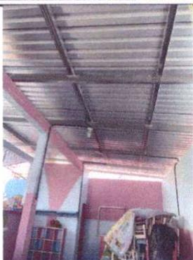
Foto1: Finalización de cambio de lámina y estructura de lámina, Salón Párvulos 3.
