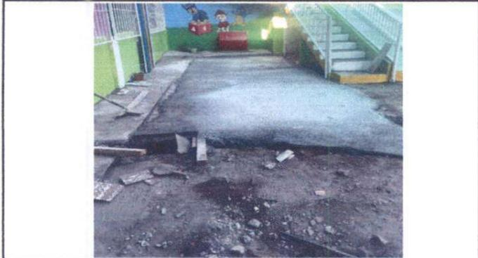
Foto 1: Iniciación de colocación de piso concreto
