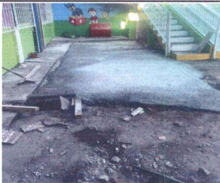
Foto1: Iniciación de colocación de piso concreto
