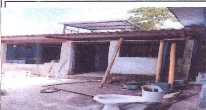
Foto 3: Sustitución de cubierta de lámina y estructura de soporte de metal, aplicación de pintura y sustitución de sistema eléctrico en cocina exterior.
