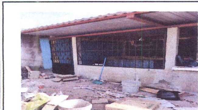
Foto 1: Reparación de área de cocina, sustitución de piso de torta de concreto por piso cerámico, suministro de gabinetes de concreto revestido de azulejo, sustitución de pila de dos lavaderos y sustitución de
