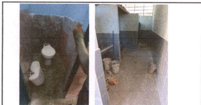
Foto 5: Colocación de azulejos en baños de señoritas y varones.
