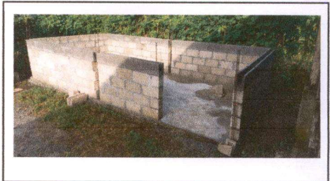
Foto 2: Mejoramiento del espacio para cocinar.
