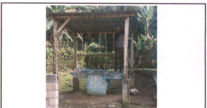
Foto 6: Mejoramiento de la mediagua que cubre la pila.
