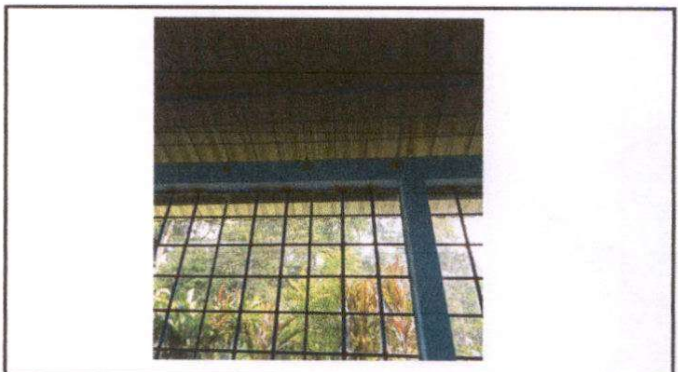
Foto 4: Reforzamiento con hierro en los ventanales.
