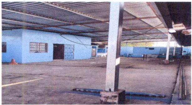
Foto 3: Sustitución estructura de soporte de metal por metal salón de usos múltiples
