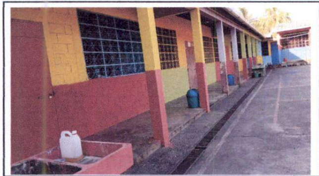
Foto1: Suministro de pintura, exterior de los salones módulo dos
