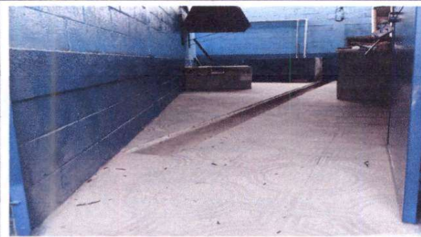
Foto 3: Sustitución de piso cerámico por piso cerámico antideslizante para la cocina
