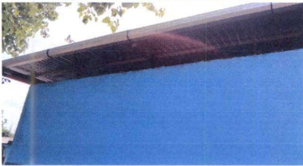
Foto 3: Suministro de canal de metal americano calibre 26 para salón de usos múltiples
