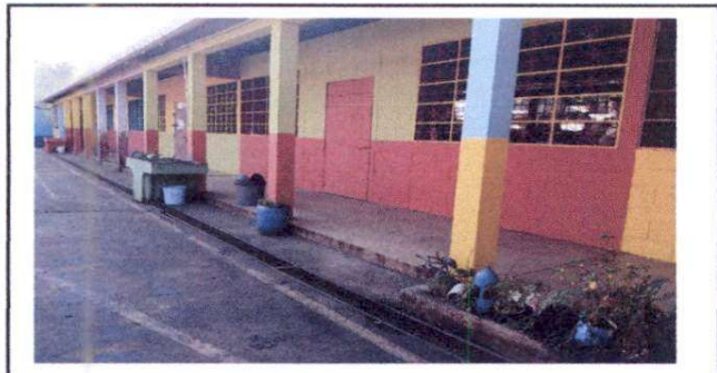
Foto 5: Suministro de pintura, exterior de los salones módulo dos
