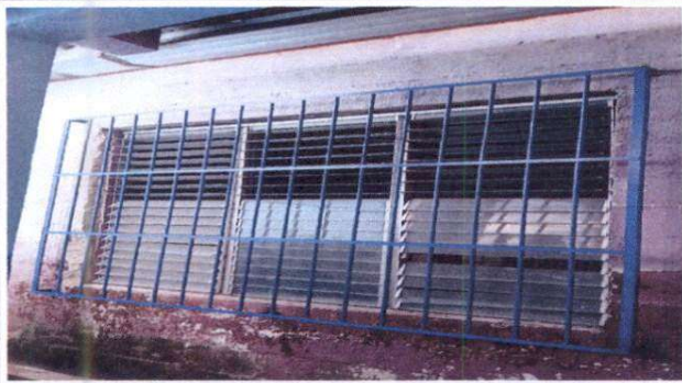
Foto1: Suministro e instalación de balcón para salón de 3ro "B"
