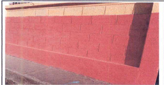
Foto 3: Suministro de pintura, exterior de los salones módulo dos
