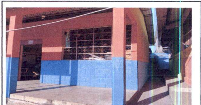
Foto 4: Suministro de pintura, exterior de los salones módulo dos
