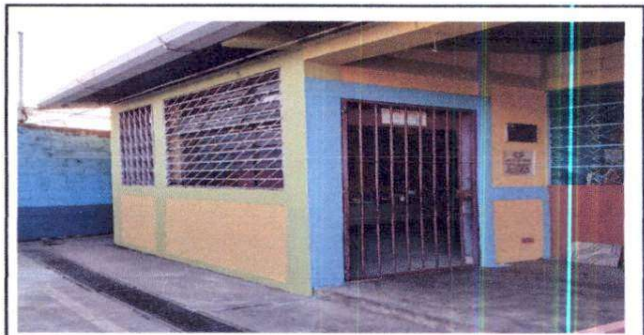
Foto 6: Suministro de pintura, exterior de los salones módulo dos
