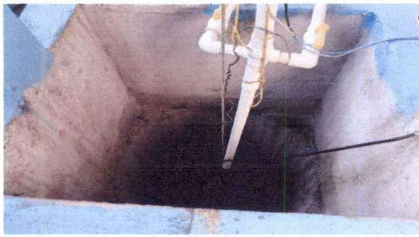
Foto 1: Sustitución de bomba sumergible para abastecimiento de agua del pozo artesanal
