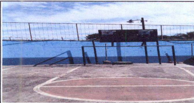
Foto 5: Suministro de pintura para muro exterior e interior del centro educativo
