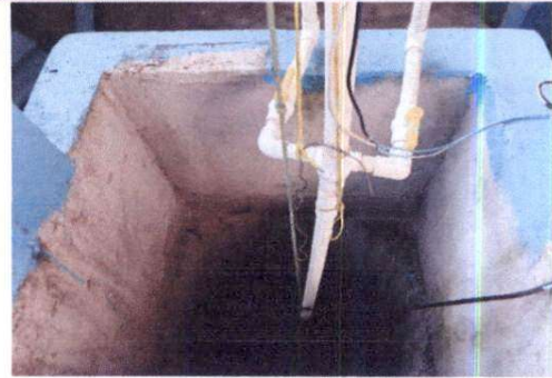
Foto 2: Sustitución de bomba sumergible para abastecimiento de agua del pozo artesanal
