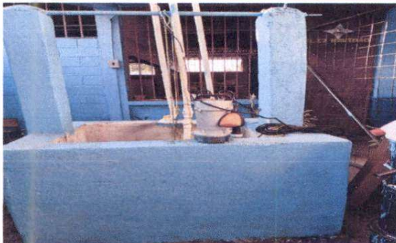
Foto 3: Sustitución de bomba sumergible para abastecimiento de agua del pozo artesanal
