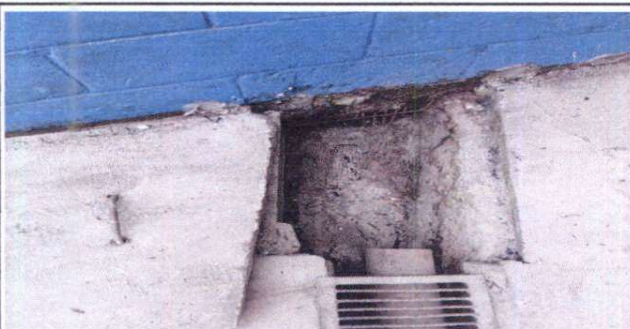
Foto 5: Mantenimiento a reposaderas
