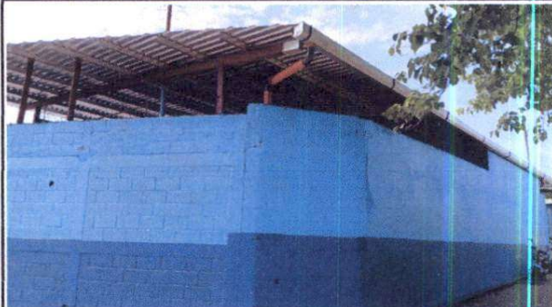
Foto 2: Cubierta de lámina acanalada por troquelada zintroalum, salón de usos múltiples
