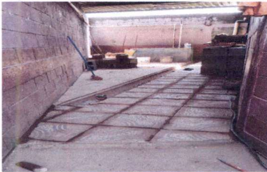
Foto 3: Sustitución de piso cerámico por piso antideslizante para la cocina
