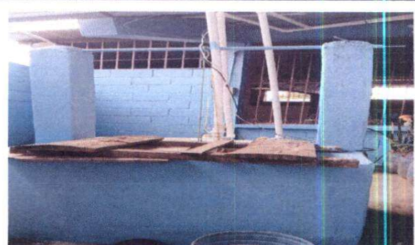
Foto 2: Sustitución de bomba sumergible para abastecimiento de agua del pozo artesanal
