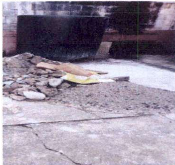
Foto 5: mantenimiento a reposadera
