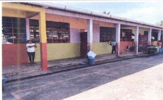
Foto 5: Suministro de pintura, exterior de los salones módulo dos
