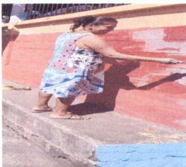
Foto 3: Suministro de pintura, exterior de los salones módulo dos
