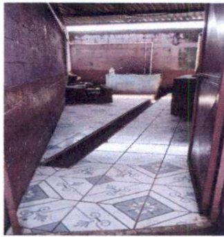
Foto1: Sustitución de puerta con chapa para cocina
