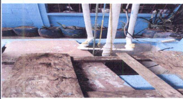
Foto 1: Sustitución de bomba sumergible para abastecimiento de agua del pozo artesanal
