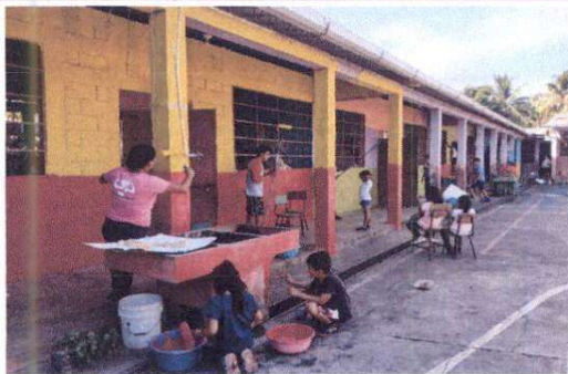
Foto 1: Suministro de pintura, exterior de los salones módulo dos
