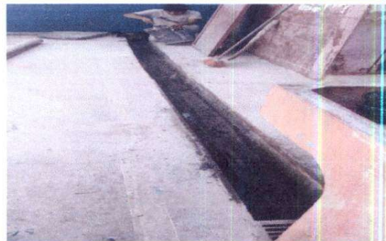
Foto 4: mantenimiento a reposadera
