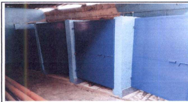
Foto 5: Suministro e instalación de puertas con pasador para 5 servicios sanitarios.
