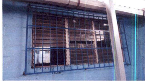
Foto 2: Suministro e instalación de balcón para salón de 3ro. "B"
