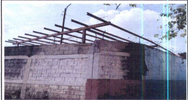
Foto 2: Cubierta de lámina acanalada por troquelada zintroalum, salón usos múltiples
