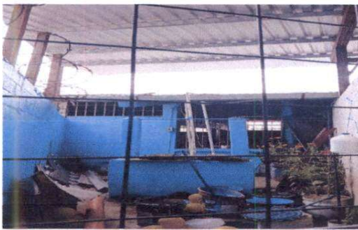
Foto 3: Sustitución de bomba sumergible para abastecimiento de agua del pozo artesanal
