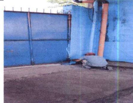
Foto 4: Suministro de bajada de agua pluvial PVC 4" para Salón de usos múltiples
