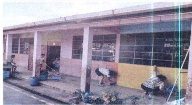
Foto 2: Suministro de pintura, exterior de los salones módulo dos
