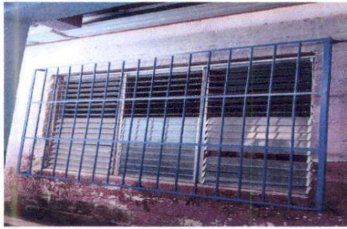
Foto1: Suministro e instalación de balcón para salón de 3ro. "B"
