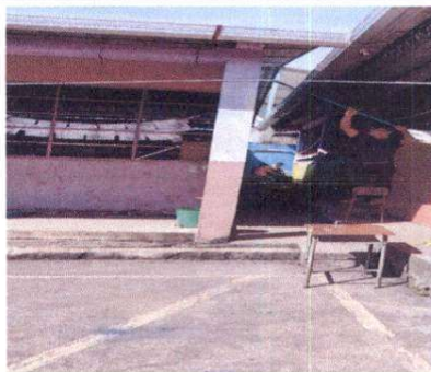
Foto 4: Suministro de pintura, exterior de los salones módulo dos
