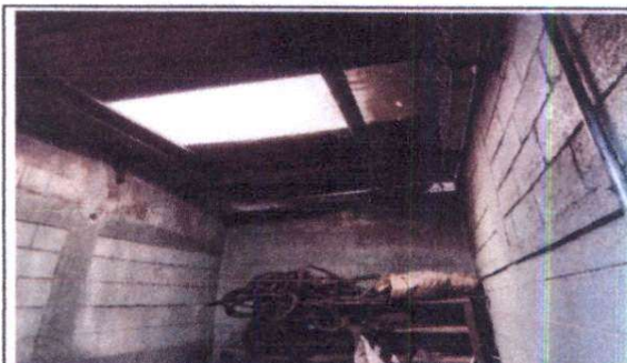
Foto 4: sustitución Estructura de soporte de metal por metal y techado de bodega de cocina
