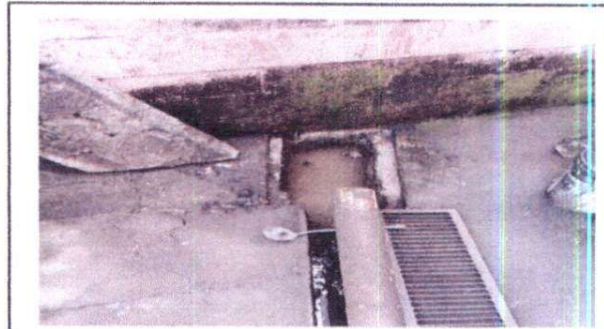
Foto 4: Mantenimiento a reposadera
