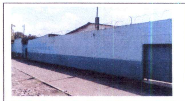
Foto 6: Suministro de pintura para muro exterior e interior del centro educativo
