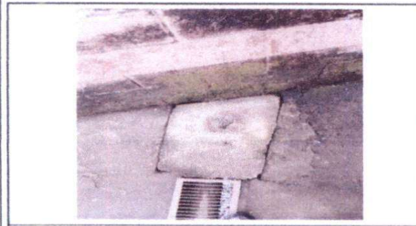
Foto 5: Mantenimiento a reposadera.
