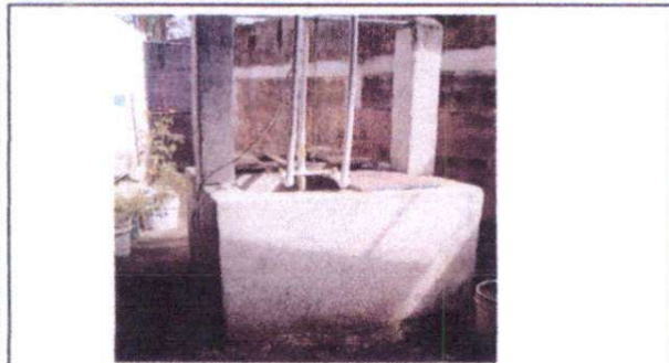
Foto 1: Sustrucción de bomba sumergible para abastecimiento de agua del pozo artesanal
