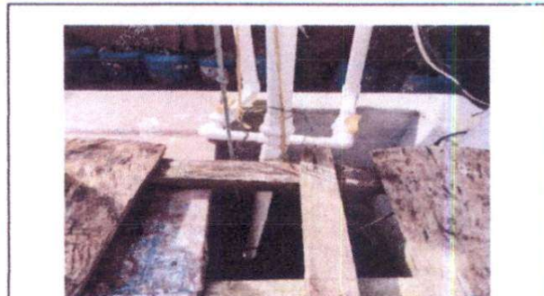
Foto 2: Sustrucción de bomba sumergible para abastecimiento de agua del pozo artesanal
