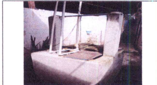
Foto 4: Sustrucción de bomba sumergible para abastecimiento de agua del pozo artesanal
