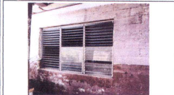
Foto 1: Suministro e instalación de balcón para salón de 3ro. "B"
