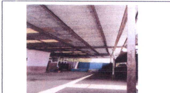
Foto 3: sustitución Estructura de soporte de metal por metal salón usos múltiples
