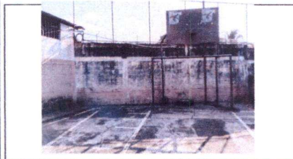
Foto 5: Suministro de pintura para muro exterior e interior del centro educativo
