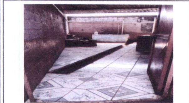
Foto 3: Sustitución de piso cerámico por piso cerámico antideslizante para la cocina
