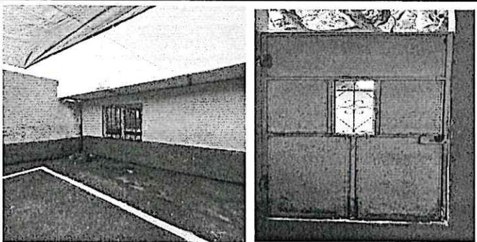
Sustitución de balcon de estructura metálica, levantado de muro para mejorar altura y sustitución de puerta de metal en aula
