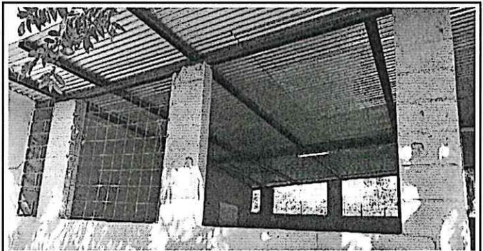
Sustitución de balcones de electromalla por estructura metálica
