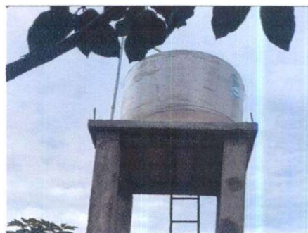
FOTO 6: Sustitución de deposito de agua.
