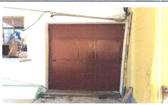
Foto 2: Sustitución de puerta de madera a puerta de metal.
