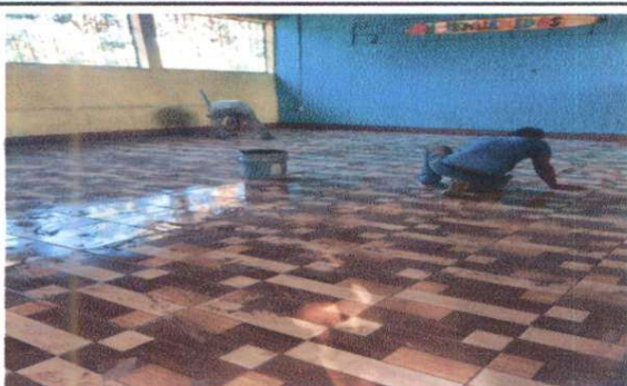
Foto1: sustitución de torta de cemento a piso ceramico aula,
