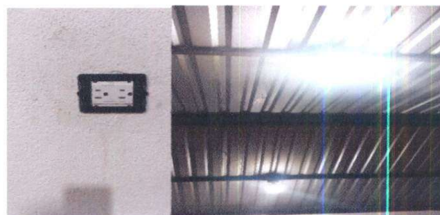
Foto 4: Instalación de energia electrica.
