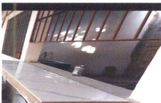
Foto 3: Mantenimiento de estructura de metal de ventanas.
